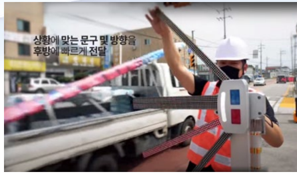
공사로 인한 도로교통 통제
